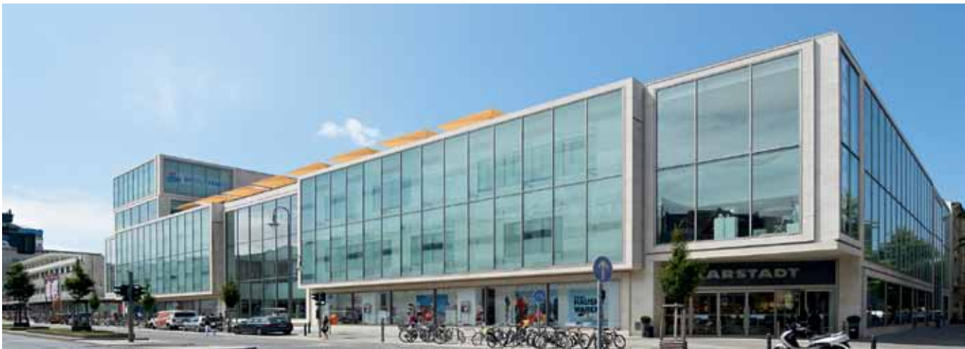
Centro comercial Boulevard Berlin con productos Hörmann, certificado breeam
